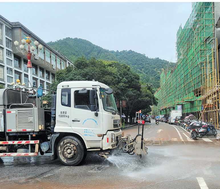
▲强降雨过后,县住建局组织开展路面清淤作业,恢复路面干净整洁。(县住建局供图)
