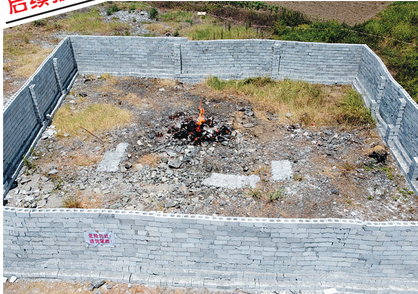
▲那羊屯可燃气体着火点已被围墙围起。
