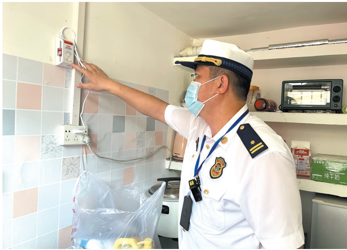
▲消防监督员对消防设施进行测试。(陆仁凤 摄)
