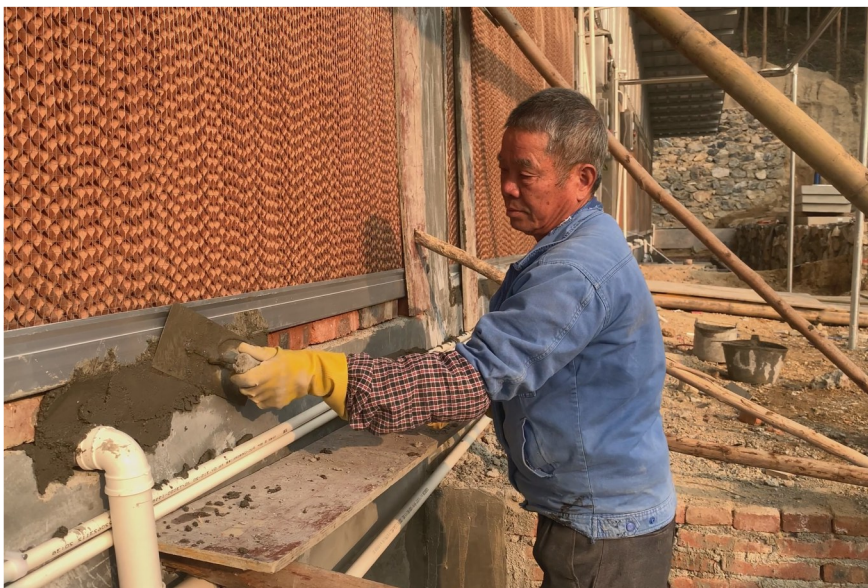
▲2月15日，在河里镇洛满村生猪养殖项目建设现场，工人正在进行猪舍外墙施工。该项目以“村企联合”抱团发展模式，与广西正大畜禽有限公司联合，由洛满村股份经济合作社与合山市洛满养殖专业合作社提供生猪养殖场地以及配套生产设施，正大公司负责提供养殖技术和销售渠道。目前场地内道路硬化、污水处理系统等工程正在紧锣密鼓中有序推进，投产后预计每年可出栏生猪4800头。（廖 松 李品艳 摄）
