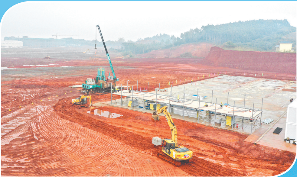
建设中的广东省(肇庆)大型产业集聚区鼎湖莲花-富溪市管起步区。
