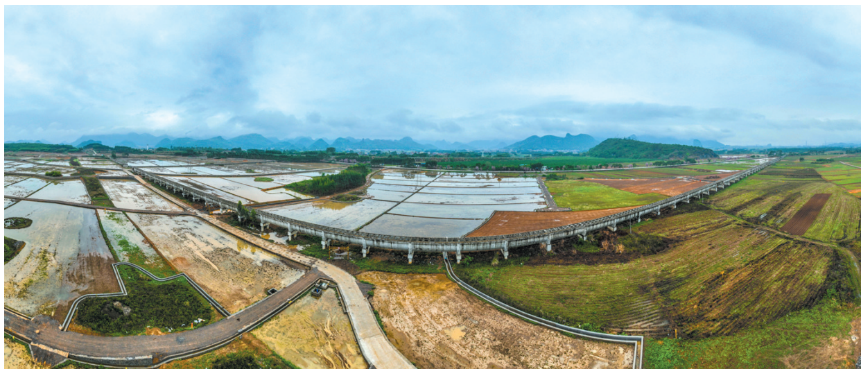
▲良江镇塘圩村耕地提质改造(旱改水)项目村片区(无人机航拍)。(特约摄影记者 盘摄波 摄)
