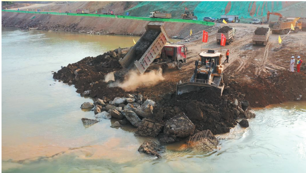
▲2019年，钱堤火热修筑中。(廖燕东 摄)
