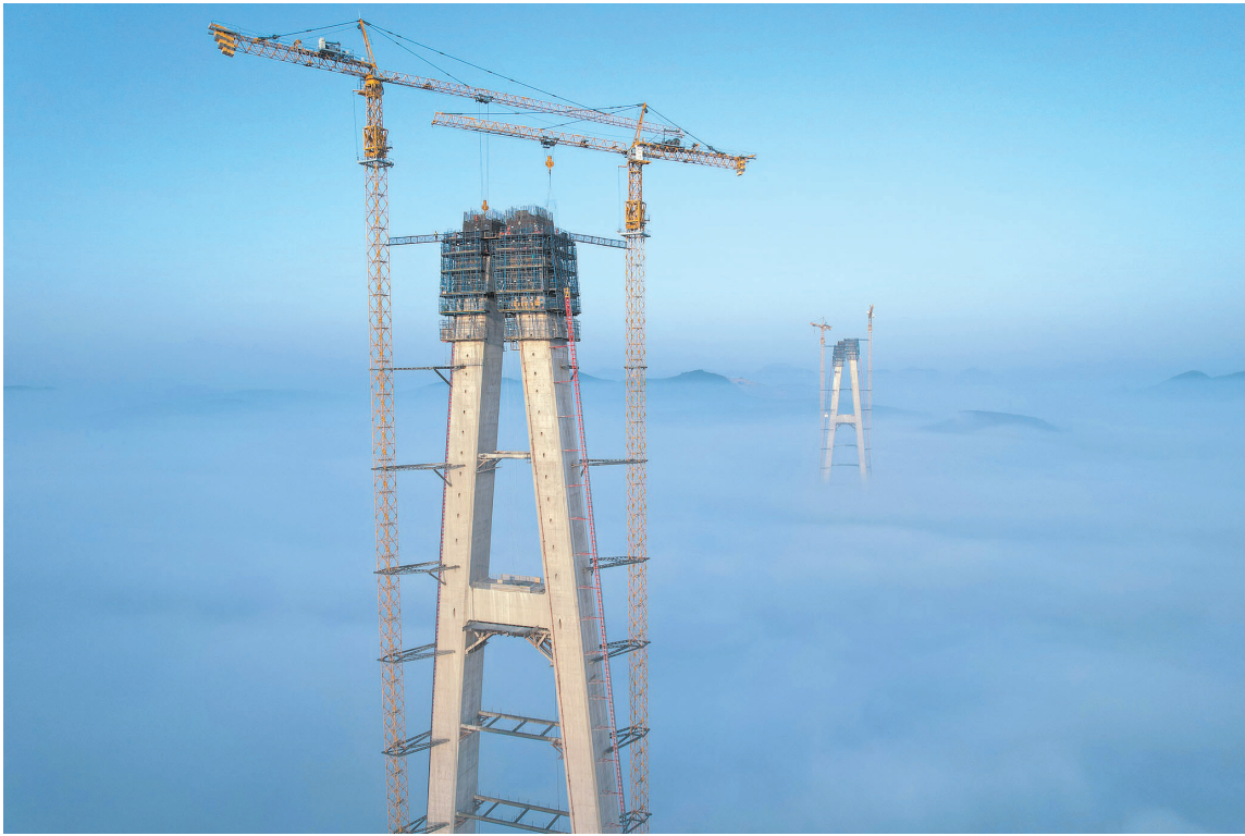
▲4月16日，广西在建最大跨径、最高索塔斜拉桥——武忻高速武宣黔江特大桥完成7#索塔右幅塔肢第36节混凝土浇筑，建设高度突破200米，预计今年6月初实现封顶。（陈洪安 莫刚军 摄）
