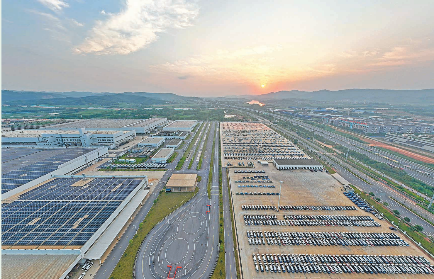
▲广西南宁市伶俐工业园区新能源汽车生产基地(2024年5月14日摄,无人机照片)。新华社发
