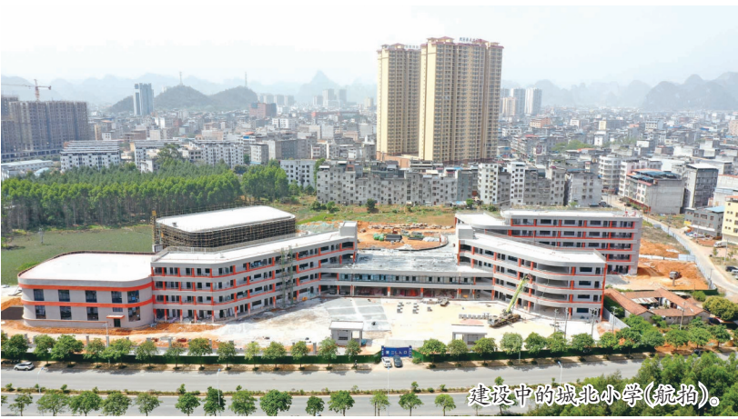
建设中的城北小学(航拍)。
