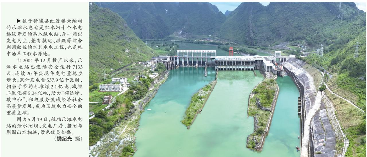
位于忻城县红渡镇六纳村的乐滩水电站是红水河十个水电梯级开发的第八级电站，是一座以发电为主，兼有航运、灌溉等综合利用效益的水利水电工程，也是桂中治旱工程水源地。自2004年12月投产以来，乐滩水电站已连续安全运行7133天，连续20年实现年发电量稳步增长；累计发电量537.9亿千瓦时，相当于节约标准煤2.1亿吨、减排二氧化碳5.24亿吨，助力“碳达峰、碳中和”，积极服务流域经济社会高质量发展，成为区域电力安全的重要支撑。图为5月19日，航拍乐滩水电站的泄水闸、发电厂房、船闸与周围山水相连，景色优美如画。(樊绍光 摄)
