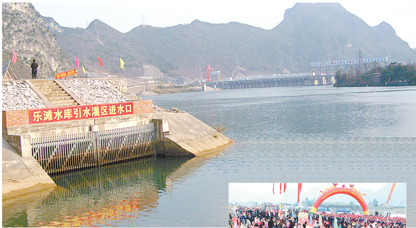
▲2006年9月,桂中治旱乐滩水库引水灌区进水口工程竣工。(乐滩建管局供图)
