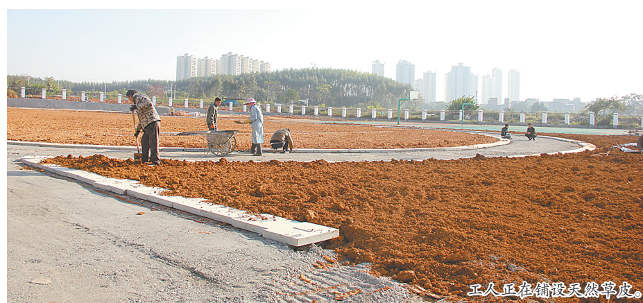
工人在铺设天然草皮。
