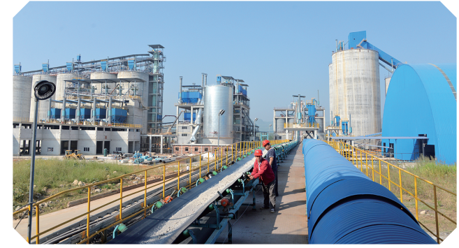
▲进驻合山产业转型工业园区正在建设的碳酸钙企业。
