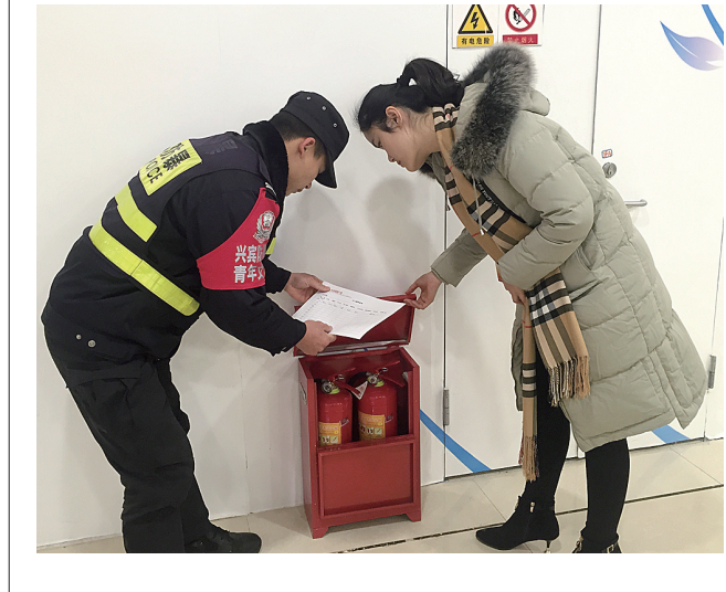
▲1月29-30日,裕达社区干部和网格安全员共同开展安全生产检查工作,分别对社区内停车场电动车充电设备和居民楼、大型宾馆和商场等消防灭火设施进行检查,确保社区居民过一个平安年。(晚刊见习记者 黄伟 通讯员 梁书 摄)
