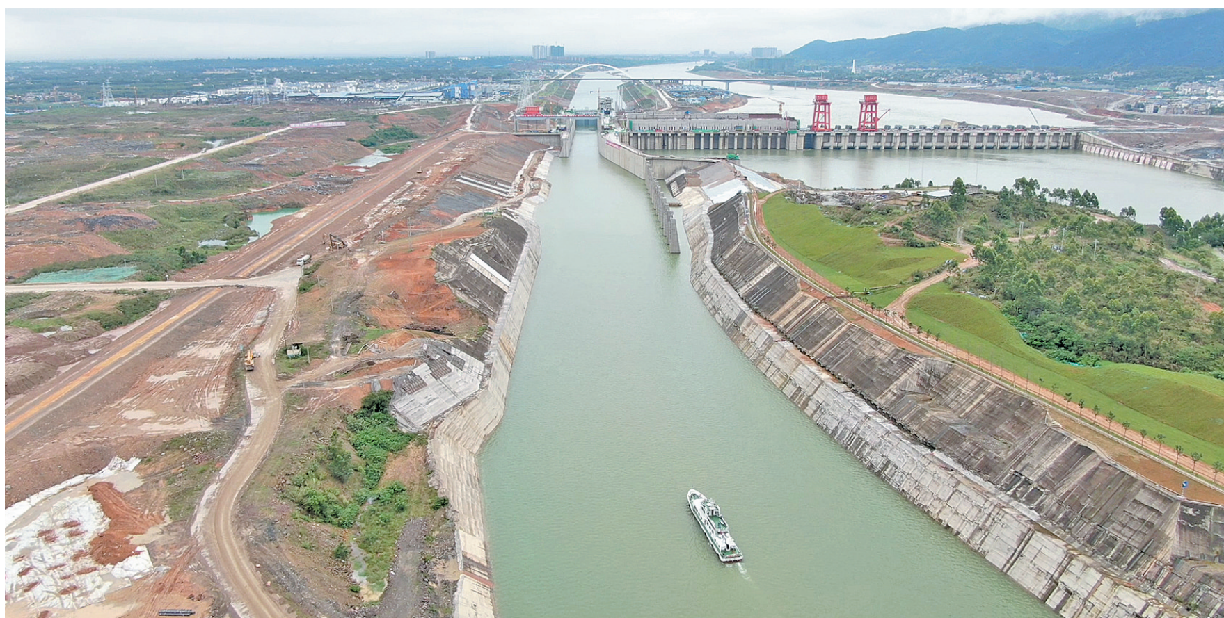
▲大藤峡水利枢纽工程船闸试通航启动。(大藤峡公司供图)
