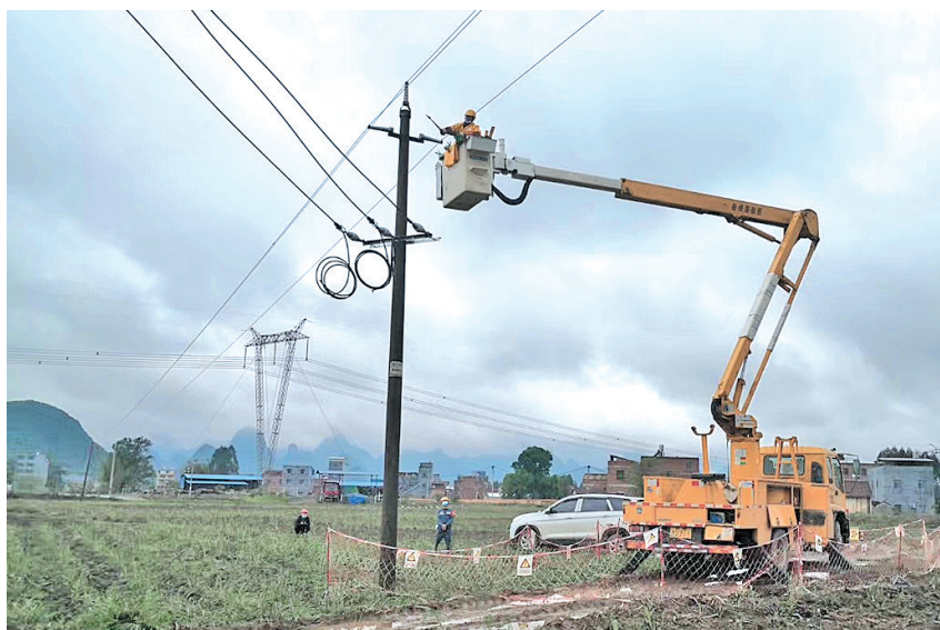
▲兴宾供电局施工现场。
