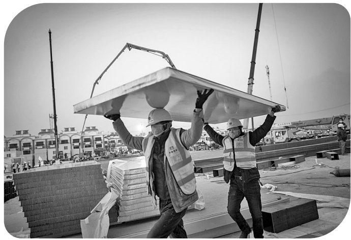
▲1月28日,在武汉火神山医院建设工地,来自中建三局的工人在加紧施工。
