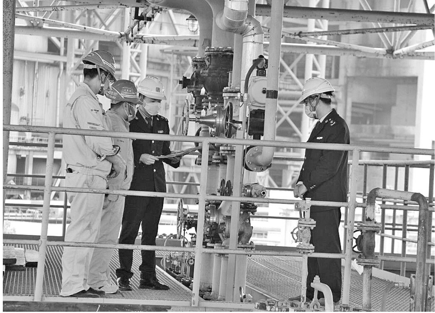
▲为保证企业安全复工复产,合山市市场监管局有序开展锅炉、起重机械、叉车、压力容器、压力管道等特种设备检查行动,共检查特种设备企业12家,发现安全隐患5处,整改5处。图为4月1日,该局工作人员到大唐桂冠合山发电有限公司检查氨气站的压力容器。(陆仁凤 摄)
