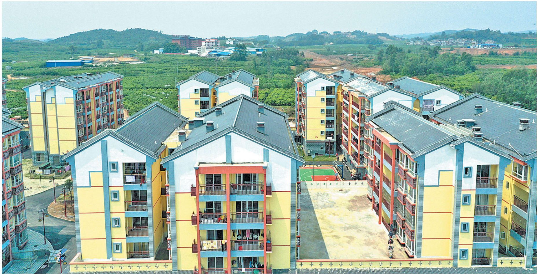
▲“金秀·幸福里”易地扶贫搬迁安置小区航拍图。
