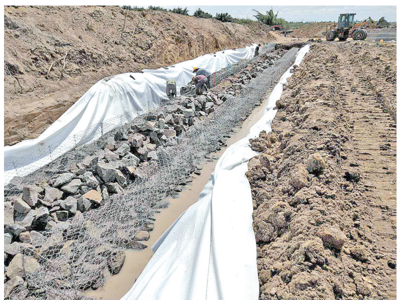
▲排水管网建设。(资料图)
