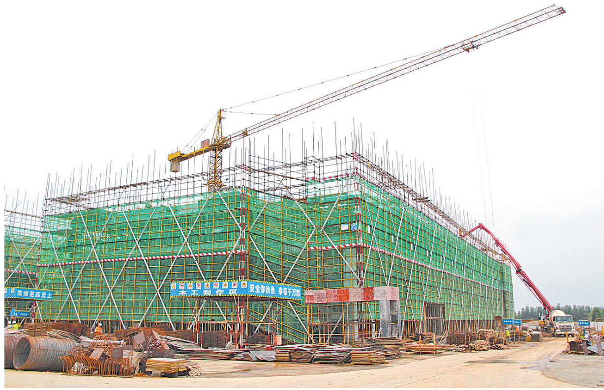
▲广西来宾中沛电子信息产业园项目建设现场。(华茜 摄)
