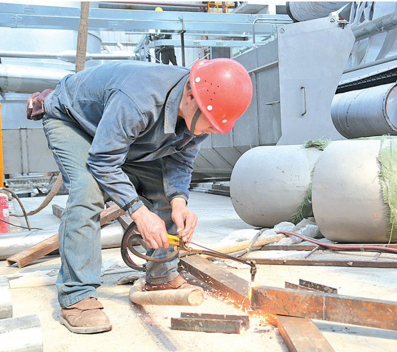
▲植护云商实业年产25万吨高端生活用纸项目建设现场。(莫家首 摄)
