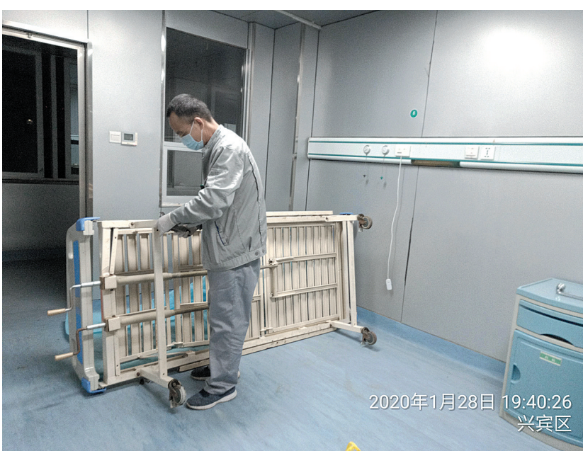
▲工人紧急为隔离病房调运、安装、调试设备。
