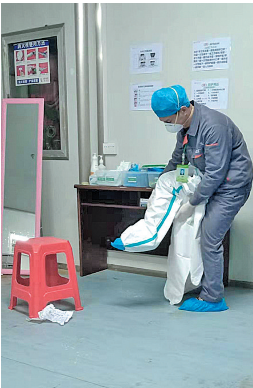
▲总务科电工穿戴防护设备，进入隔离病房抢修水龙头。
