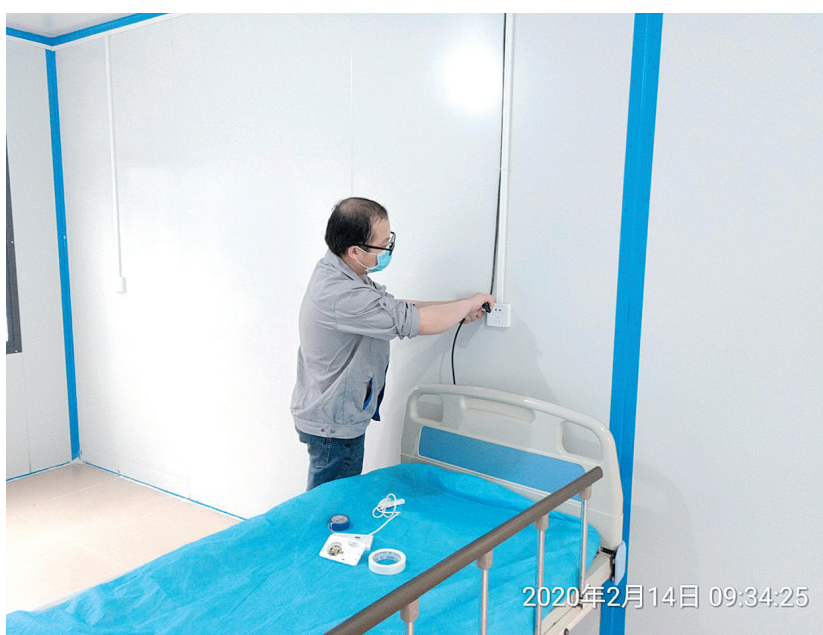
▲医疗装备维修组为发热门诊留观病房安装床头呼叫系统。
