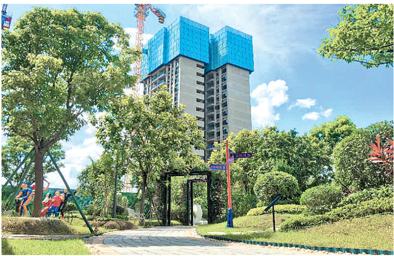
▲碧桂园正在建设中的“楼王”。
