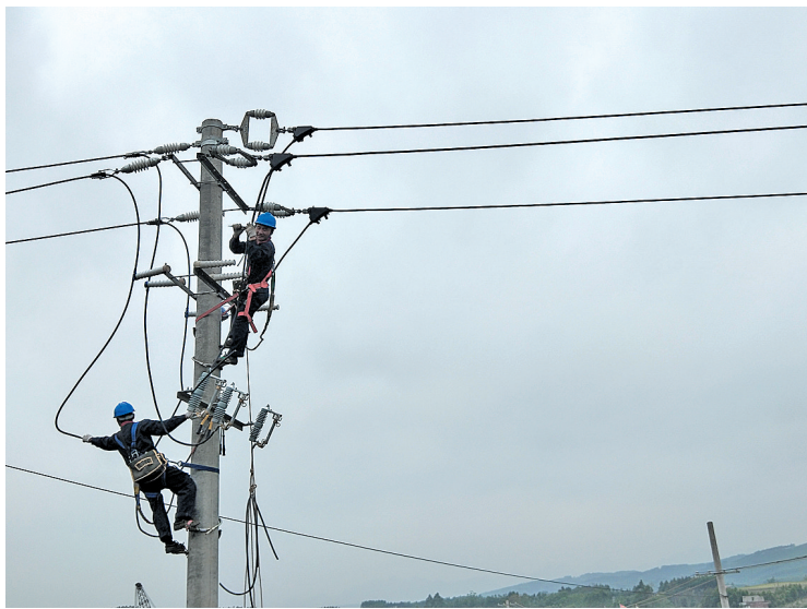
▲施工人员安装线路支线零克。
