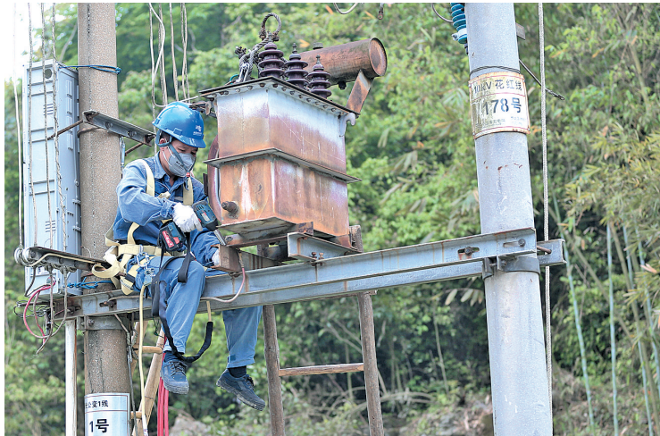
▲忻城供电局工作人员在新柳南高速公路沿线村屯更换变压器,确保高速公路建设和周边群众生产生活用电。
