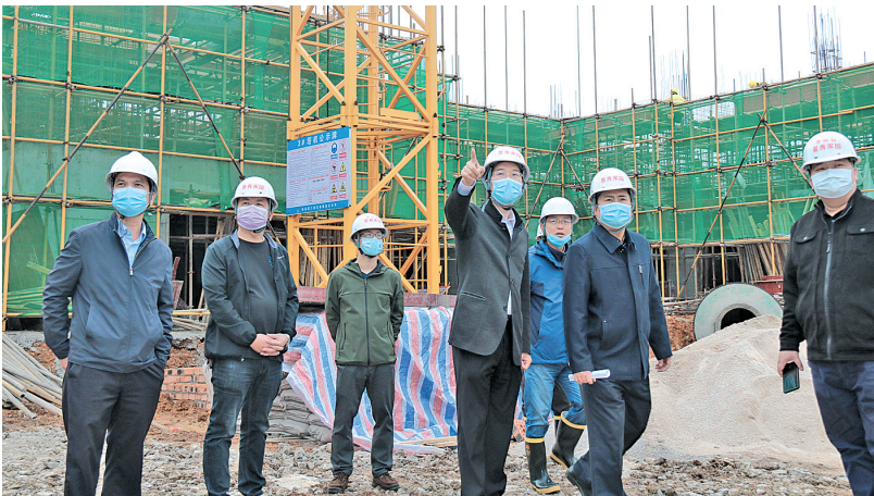
▲市住建局领导在开发商的陪同下对景秀家园建筑工地进行安全检查。
