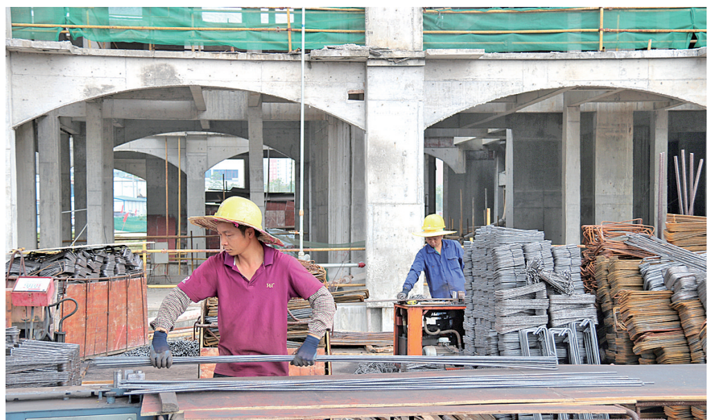
▲工人正在抓紧时间施工。
