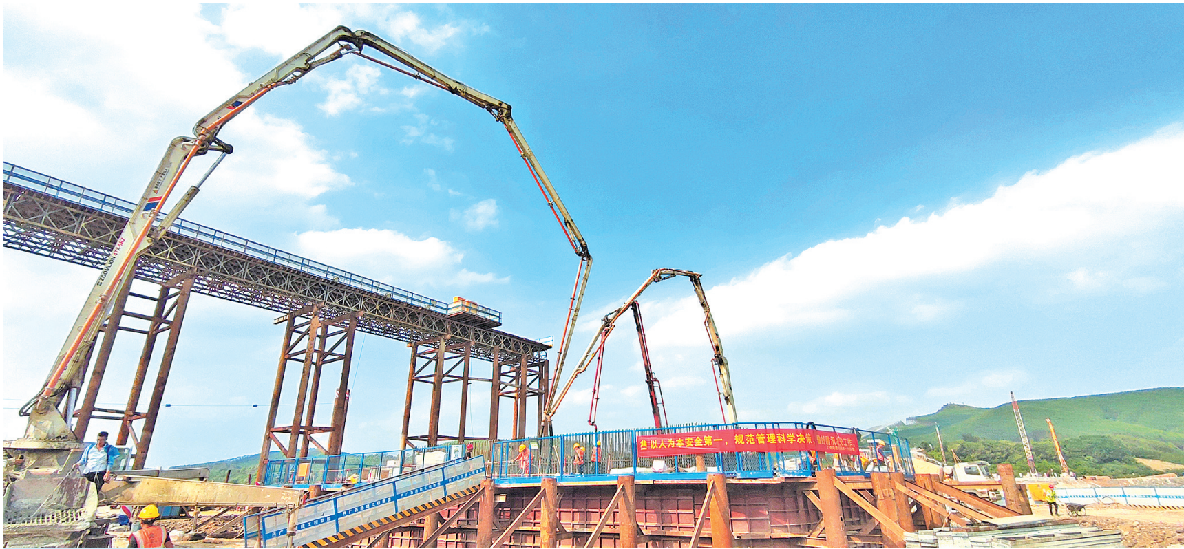
▲培森柳江特大桥来宾岸承台施工现场。
