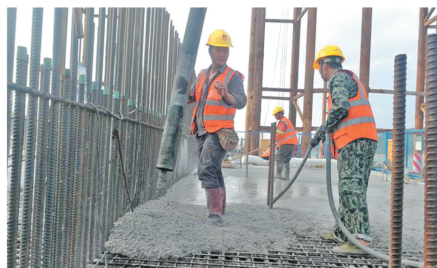
▲工人正在抓紧时间施工。
