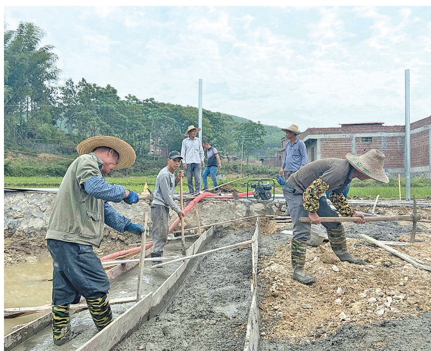
▲合山市通过中央财政专项扶贫资金,实施3个小型农田水利工程,分别是河内镇洛满村安塘屯河道综合利用建设工程、北山镇文定村上文定桥头农田灌溉建设工程、河内镇羊樟村上羊角山上塘水坝漏水修复工程。据悉,这3个项目的实施将有效解决贫困村共1473户村民4700多人生产生活用水问题。图为5月12日,安塘屯河道综合利用建设工程现场。(覃德辉 蒙姿瑾 摄)
