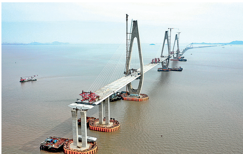
▲6月2日拍摄的在建中的舟岱大桥项目主通航孔桥(无人机照片)。
