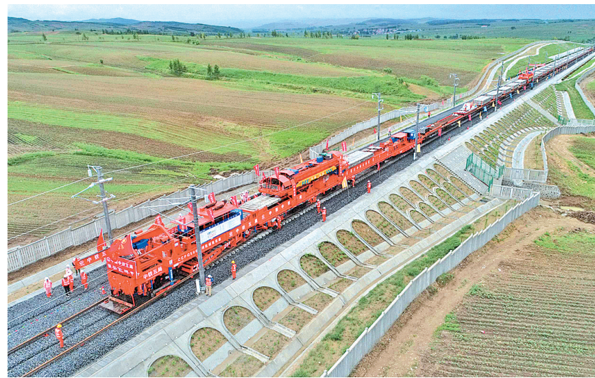
▲6月15日在黑龙江省牡丹江市林口县拍摄的杜佳客专铺轨施工现场(无人机照片)。
