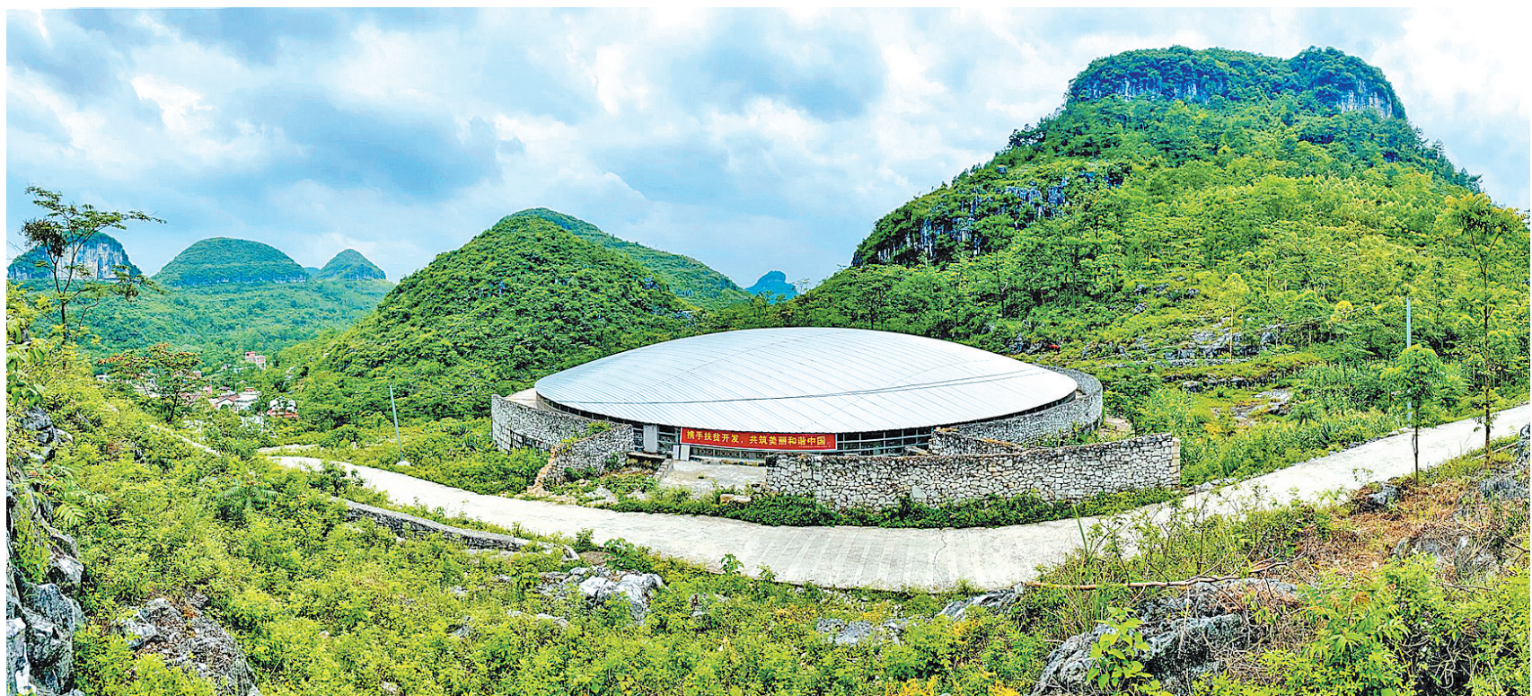
▲“有了这个盖子,我们的饮水更加安全健康!”近日,忻城县果遂镇同乐村龙鹿屯村民开心地告诉记者。据了解,龙鹿屯是一个偏僻的小山村,村民都是靠天喝水。2012年10月,该屯1万立方米的集体水柜竣工投用。由于水柜没有盖子,水柜里的水经常有杂物落入。为保障当地群众的饮水安全,龙鹿屯农村饮水安全巩固提升第一批水柜加盖工程于2019年8月开工建设,并于同年11月中旬竣工,总投资36.24万元,直接受益人口647人。图为龙鹿屯加盖的水柜。(本报记者 李冠才 摄)
