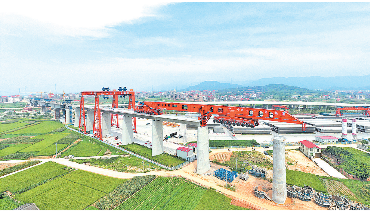
据新华社北京6月22日电 记者从中国铁建股份有限公司获悉,22日上午,中铁十一局集团建设者稳稳地将一台1000吨箱梁架设在福厦高铁湄洲湾跨海大桥上(如图),标志着我国首台1000吨级高铁箱梁运架一体机成功投入使用,我国高铁装备制造和施工水平获得重大突破。
