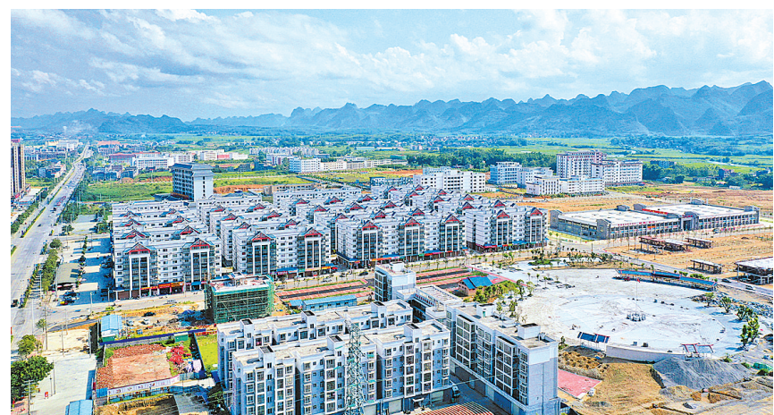
▲忻城县“十三五”时期共有易地扶贫搬迁人数5020户1.99万人。在建设移民新区时,该县充分考虑贫困户的生活需求,坚持高标准打造各个移民小区,形成了适宜居住、适宜就业、适宜就学的易地扶贫搬迁“忻城模式”,让近2万名易地搬迁群众从“搬得出、稳得住、能发展、可致富”到“乐享新生活”。图为航拍的忻城县城南易地扶贫搬迁点,道路、广场等公共服务设施正在紧张有序地施工。(潘显高 罗静 摄)
