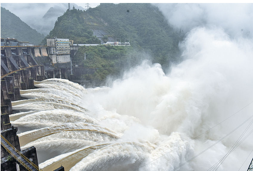
◀6月22日,风滩水库开启全部闸门泄洪(无人机照片)。受上游强降雨影响,位于湖南省沅陵县的风滩水库水位不断上涨,6月21日起全部13孔闸门开启泄洪。新华社发
