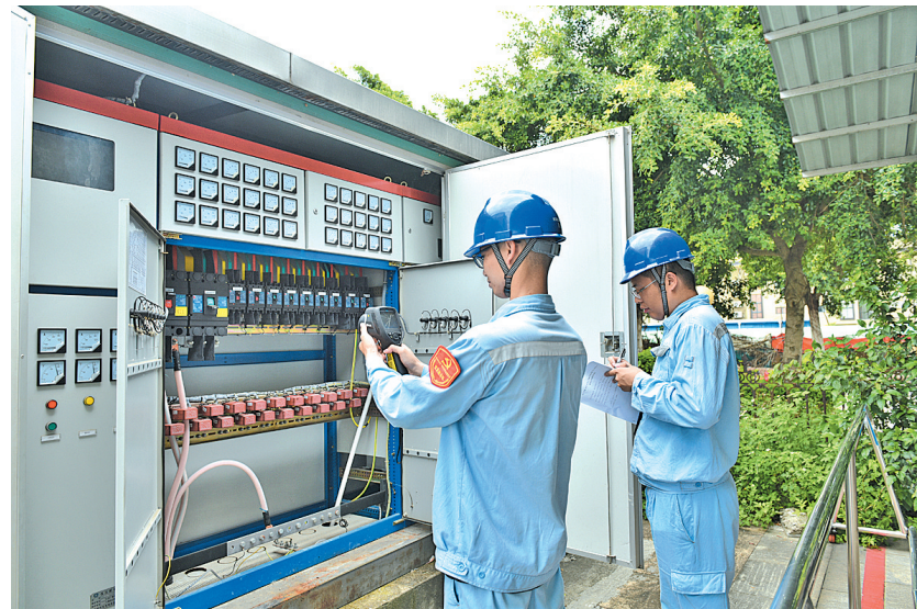
▲工作人员开展保电场所用电检查。
