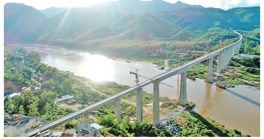
▲随着中老铁路班纳汉湄公河特大桥于日前完成架梁施工,中老铁路两座跨湄公河特大桥架梁施工任务全部完成,为中老铁路如期建成通车奠定坚实基础。图为7月15日拍摄的中老铁路班纳汉湄公河特大桥(无人机照片)。 新华社发
