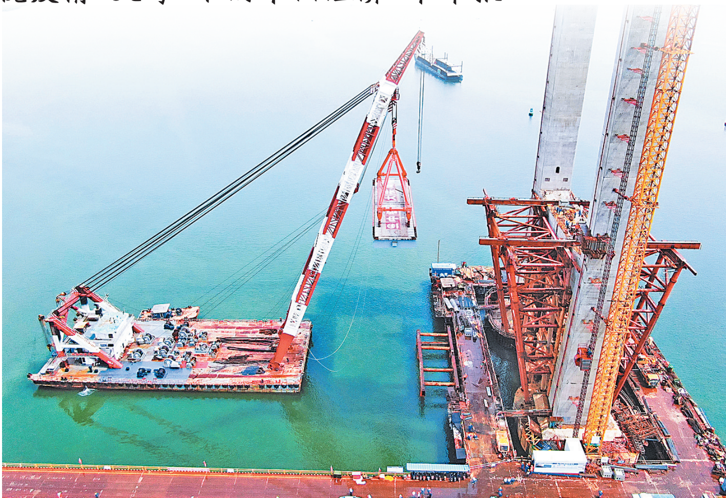
▲这是5月29日拍摄的广东湛江调顺跨海大桥施工现场(无人机照片)。新华社发
