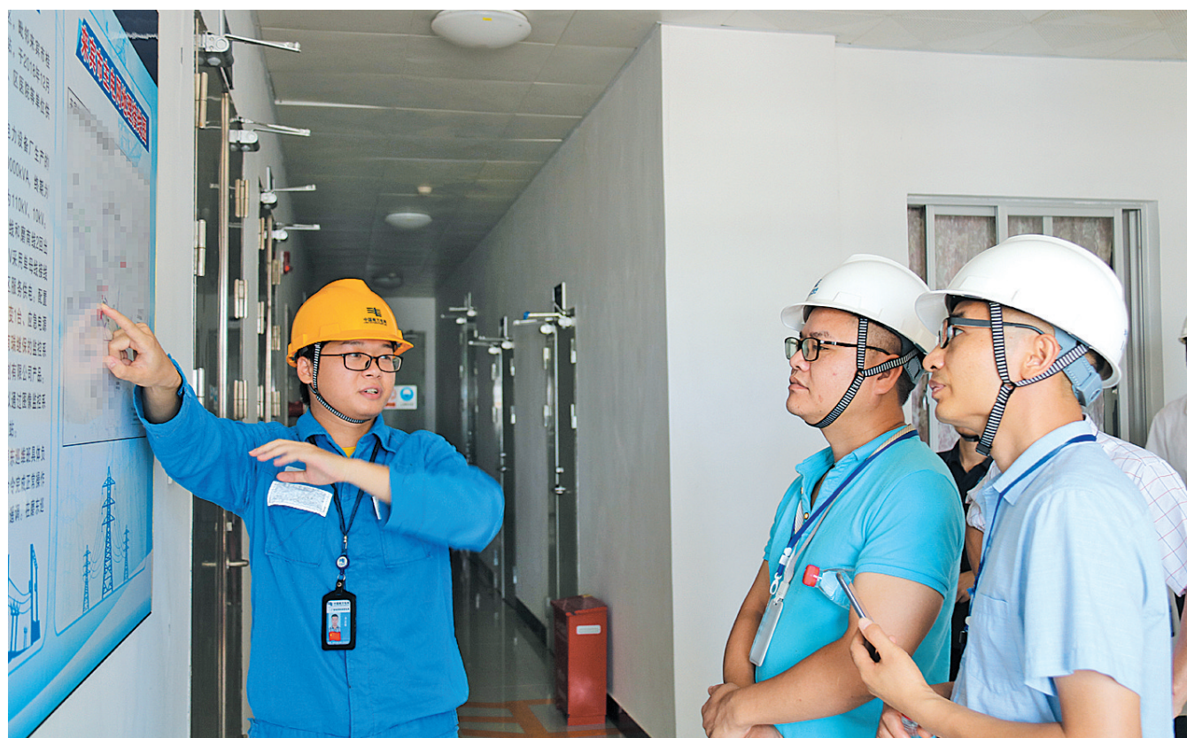
▲电网工作人员向参观者介绍变电站相关知识。
