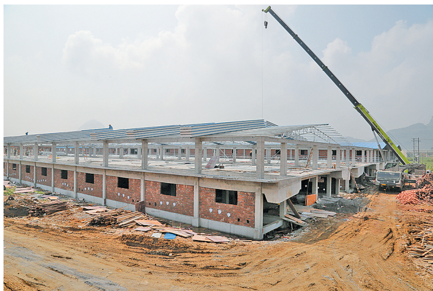
▲兴宾区迁江镇阮围村养殖场施工现场。
