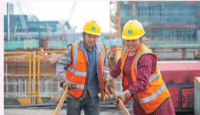
▲2月9日，在杭州萧山国际机场三期项目工地上，来自四川泸州的工人杨登平(左)、李瑞英在工作。
