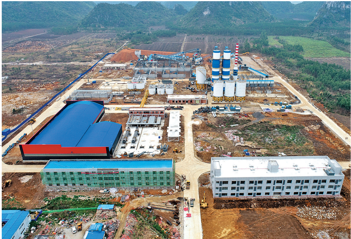
▲4月12日,位于陶邓镇的广西国浩科技有限公司碳酸钙项目正在抓紧施工。
