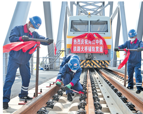
8月17日,工人在同江中俄黑龙江铁路大桥施工现场进行施工。当日,在同江中俄黑龙江铁路大桥施工现场,中俄两国准轨接口最后一组轨道夹板安装完成,标志着中俄两国首座跨江铁路大桥——同江中俄黑龙江铁路大桥实现铺轨贯通,为大桥全线开通运营奠定了坚实基础。 新华社发
