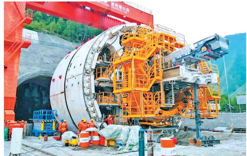
▲这是9月7日在格鲁吉亚古多里组装过程中的“高加索号”全断面硬岩掘进机。
