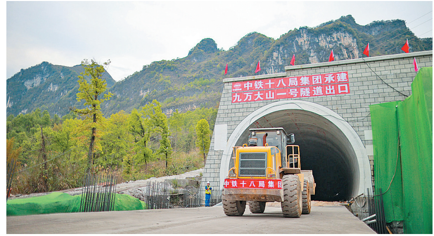
▲3月24日,施工车辆驶出九万大山一号隧道。
