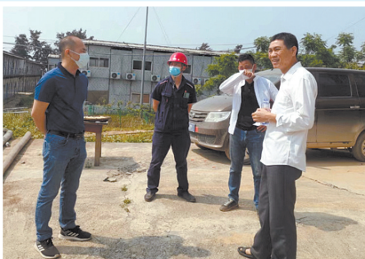
2022年4月12日,钢铁产业链分队及市特派办要素组工作人员会同港口区政府相关部门负责人前往项目业主现场协调广钢配套项目桂科用电安全问题。
