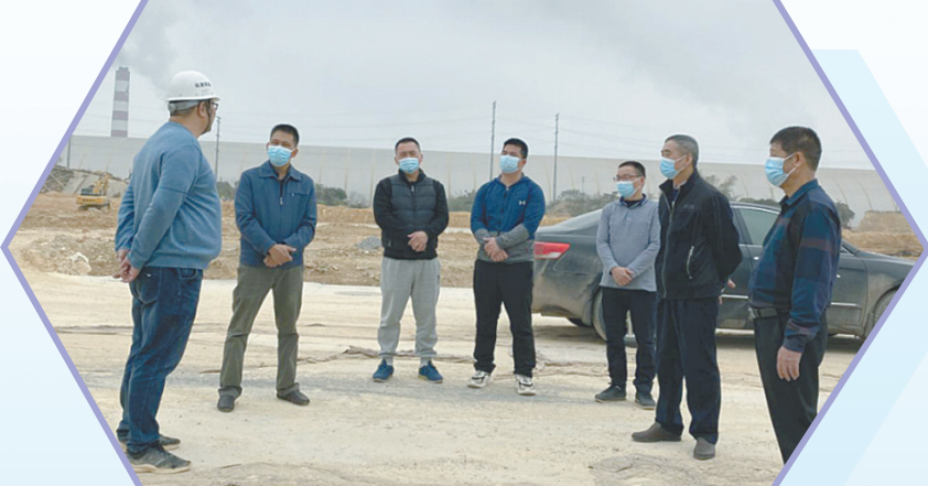
2022年3月1日,铝铝产业链分队队员到五金铜材加工项目施工现场,调研该项目建设施工进度和春节后复工复产情况,帮助企业纾困解难。
