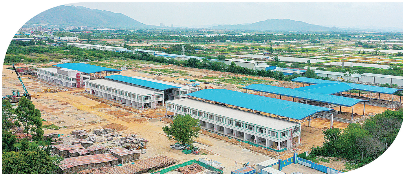
建设中的粤港澳大湾区水产品暨预制菜原材料交易中心。
