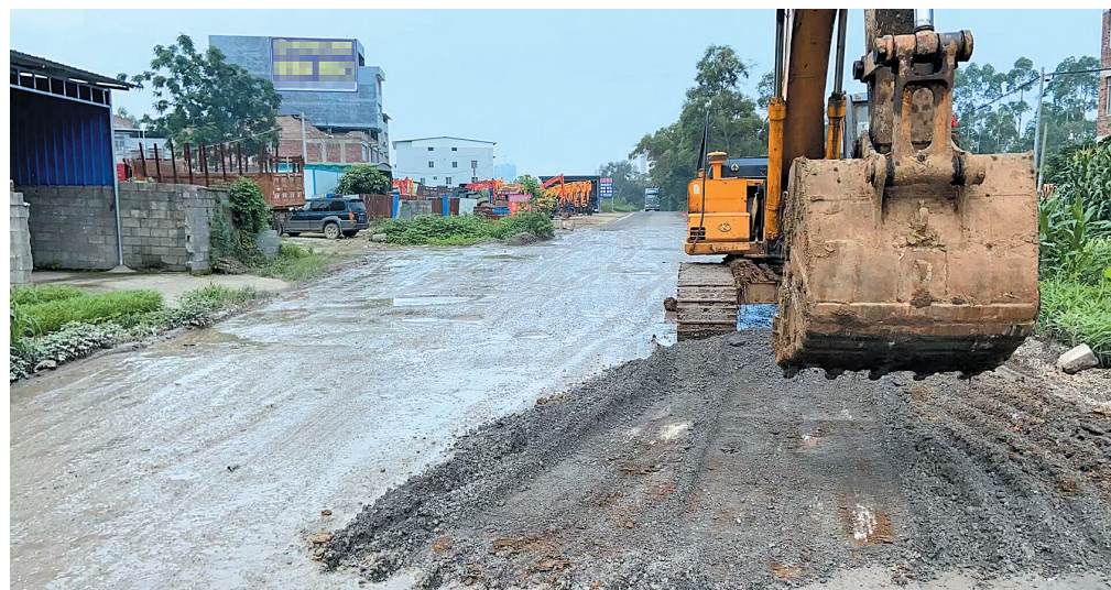
▲钩机进场铺平道路,让道路能够通行。(兴宾区住建局供图)
