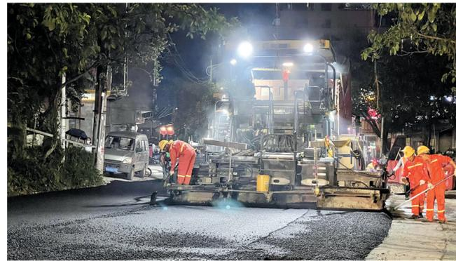
▲忻城县交通基础设施提升改造工程PPP项目目前正在有序施工。该项目道路总长28379米，主要建设内容为县城区道路、绕城主干道及清水河大道扩建及提升改造，预计2024年完工。目前，城区芝州一路二路部分白改黑工程已完成，鞍山路沥青铺设正在开展。图为7月21日晚，工人加班加点对鞍山路进行沥青铺设。(潘显高 摄)
