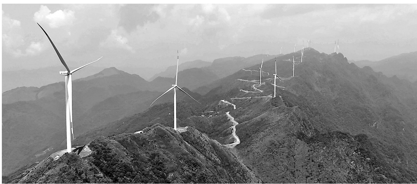
▶ 广西武宣粤风新能源有限公司投资4.82亿元建设的晴岚风电项目位于武宣县东乡镇双髻山。项目于去年底并网发电,今年年初正式投产运营。该项目共有20台2.5兆瓦风力发电机组,年发电量约1.2亿,产值约5000万元。截至目前,晴岚风电场完成发电量约9200多万千瓦时。(李干金 梁辉业 摄)
