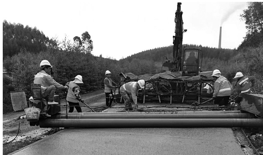
▲近日,象州县寺村经中平至大樟公路(寺村至百丈段)项目施工现场机器轰鸣,工人正有条不紊地进行路面铺设工作。目前已完成寺村镇往中平镇方向6公里(单幅)水泥混凝土路面施工,争取12月底完成寺村镇到中平镇水泥混凝土路面建设。图为施工现场。(梁修甫 摄)
